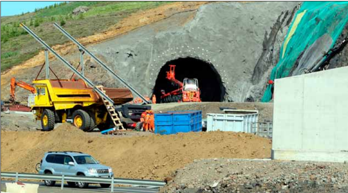
Gangamunni Vaðlaheiðarganga Eyjafjarðarmegin. Til hægri sést í bráðabirgðabru yfir þjóðveg 1.
